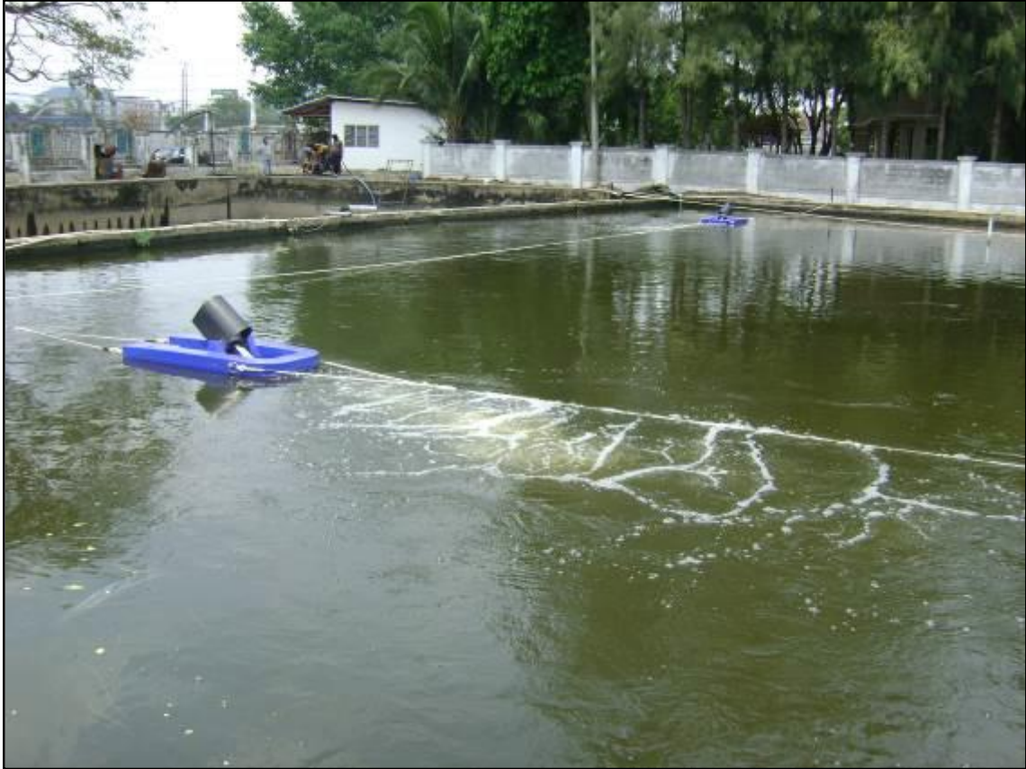
การติดตั้งเครื่องเติมอากาศได้ผิวน้ำ ( JET AERATOR ) ด้วยเชือก
